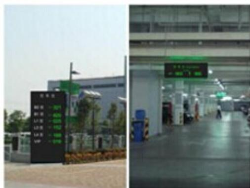
车辆停放完毕后，户外及室内的信息指示屏会自动将当前位置的空车位数扣减掉 1，完成本次车位引导。
