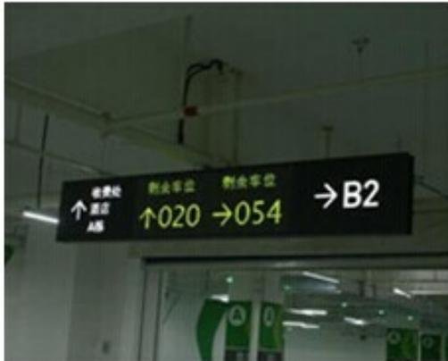
车辆进入停车场后，位于车位内部各个分岔路口的上方，安装有“信息指示屏”，显示该分岔路口所通往的各个方向当前空车位数。
