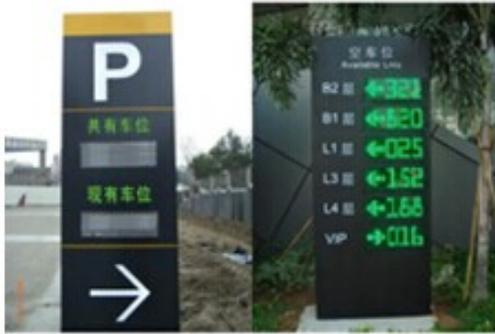
车主驾车进入停车场前，可以通过安装在停车场总入口处的“入口信息引导屏”上空车位的显示，了解停车场各层当前的空车位数。
